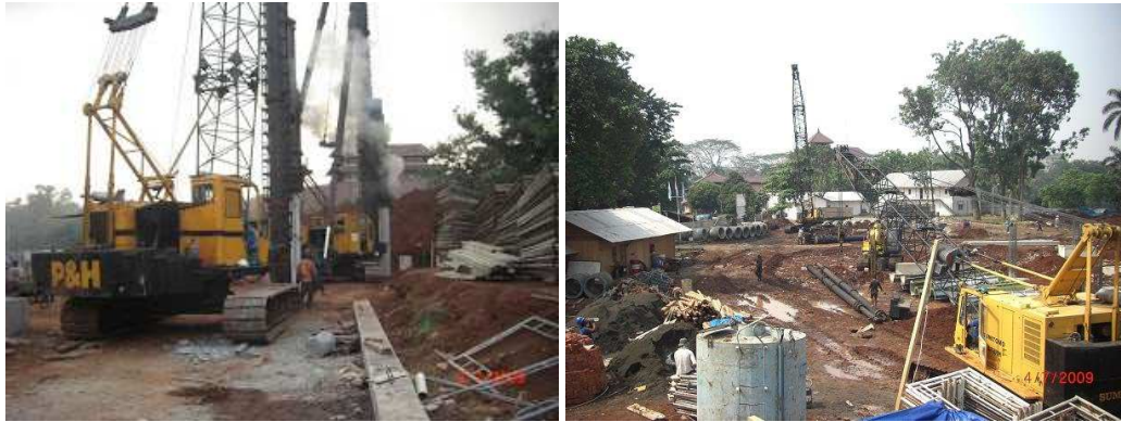
Gambar 1. Pemancangan Tiang Pancang
