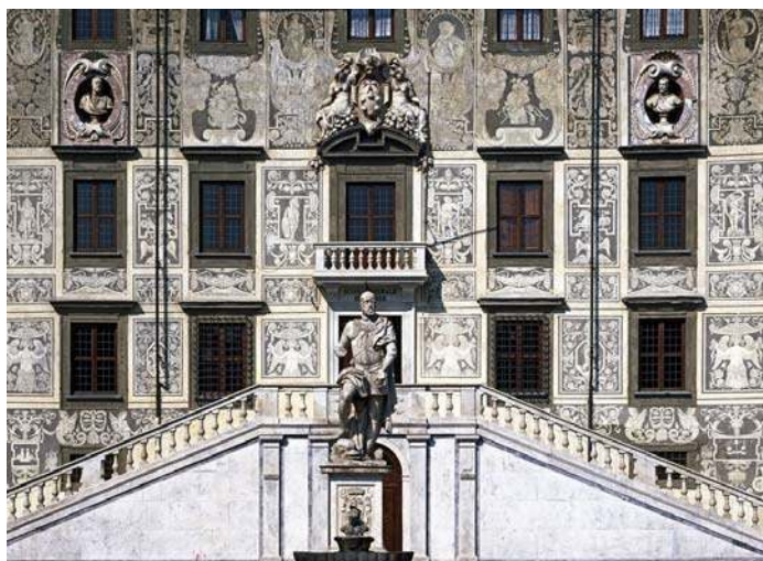
3.6 pav. Sgrafito technika Carovana rūmai, Piza, Italija Fig. 3.6. Sgraffito technique Palazzo della Carovana, Pisa, Italy
