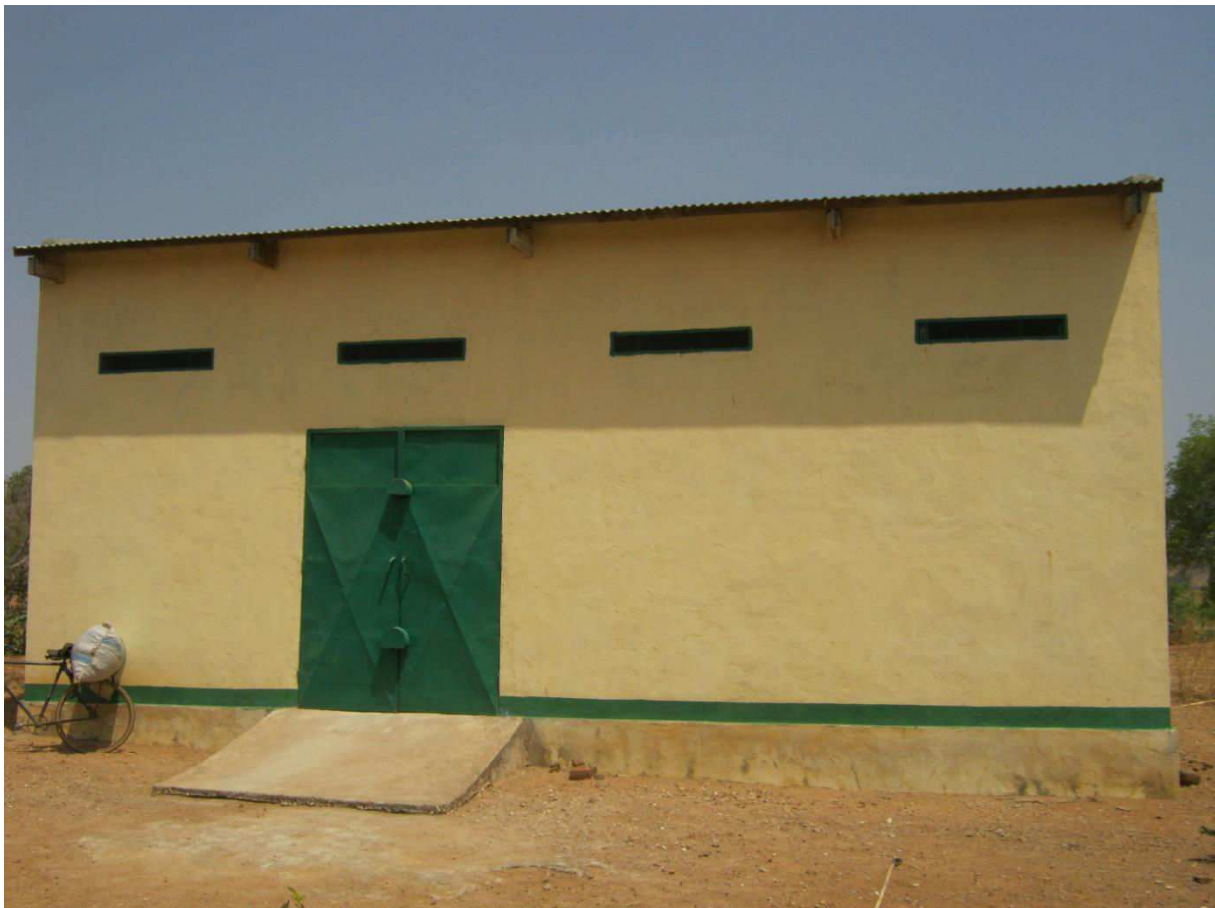
Photo 6: Exemple d'un magasin de stockage à Zabilly
