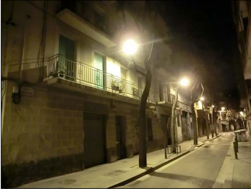
Figura 16. Ejemplo de intrusión lumínica en la calle Andalucía.
