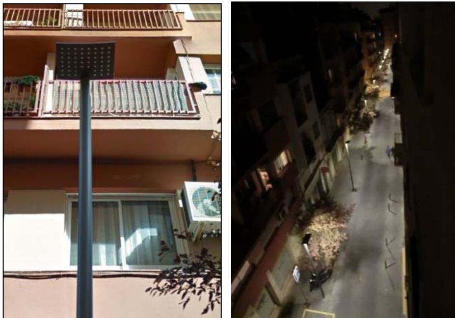
Figura 15. Imagen nocturna tomada desde arriba de las luminarias de leds 3 .
