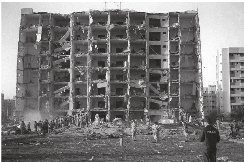
Figur 4.1. Skador av tryckvågen vid bombningen av Khobar Tower den 25:e juni, 1996. (Foto: US Air Force, i public domain)
