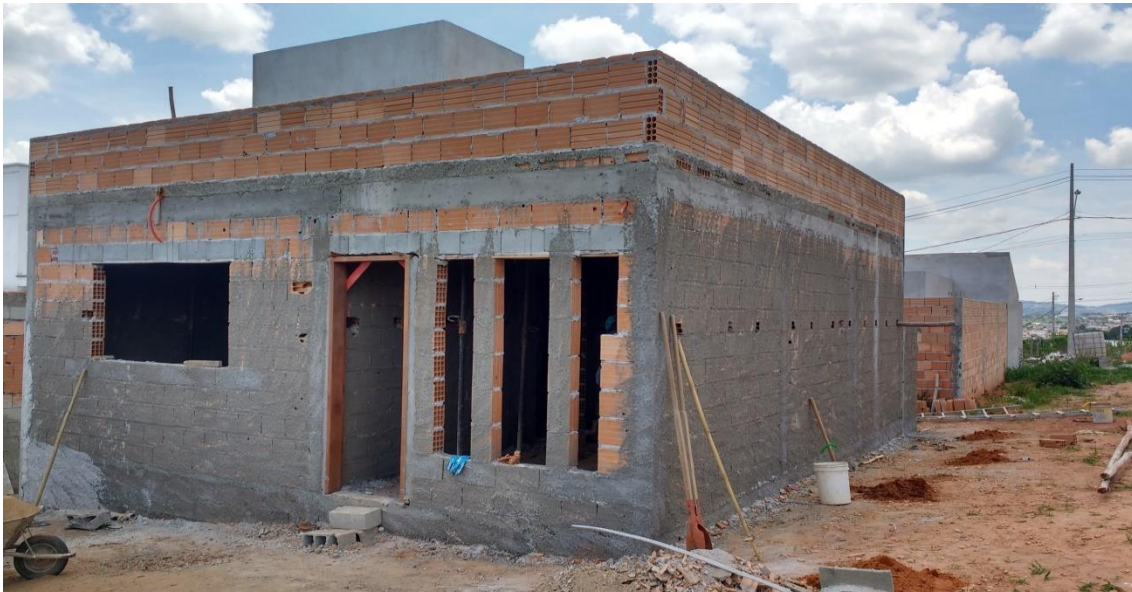
Figura 05 – Método convencional de alvenaria e concreto armado
