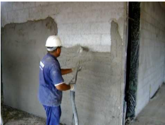
Figura 01 – Uso do projetor de argamassa
