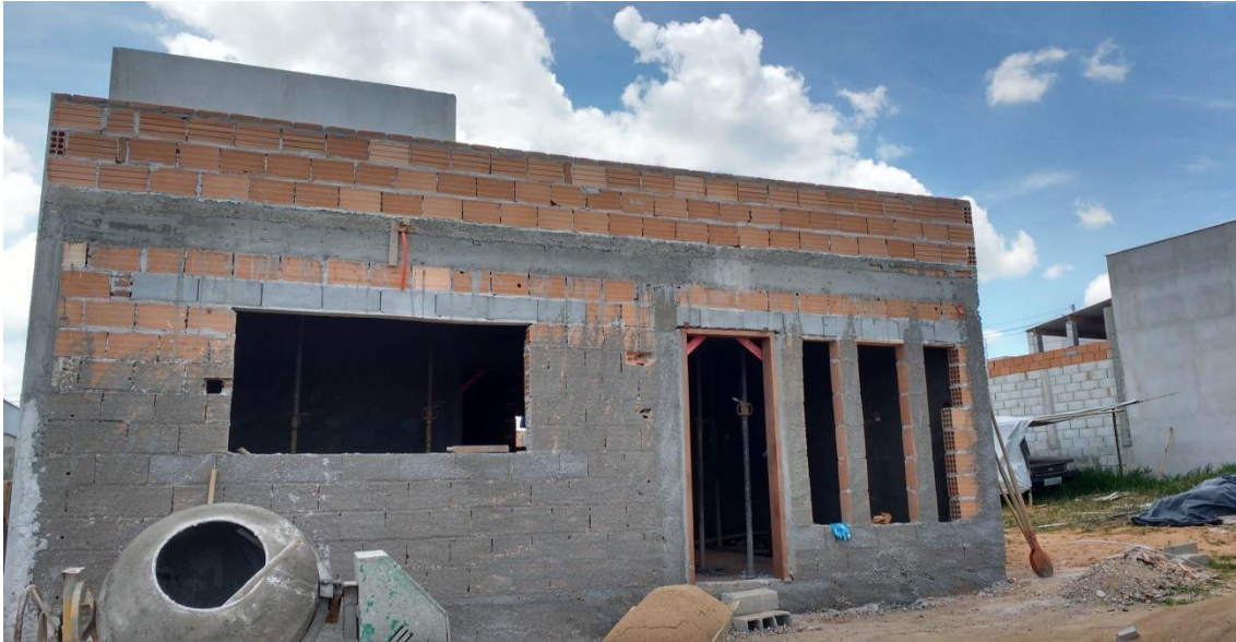
Figura 04 – construção sem canteiro de obra
