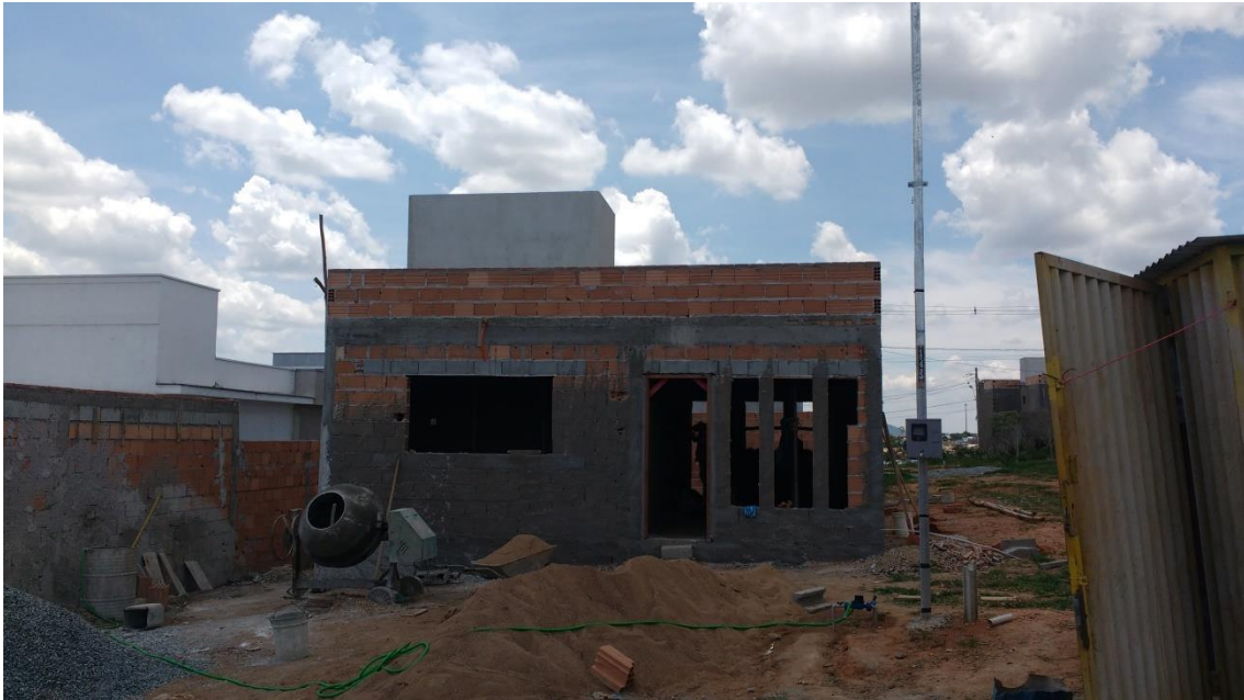
Figura 03 – construção sem canteiro de obra
