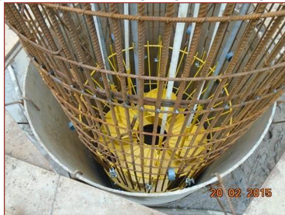
Figura 9. Instalação da armadura com o suporte para células expansivas na perfuração.
