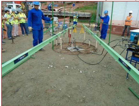
Figura 10. Montagem das barras de referência para execução do ensaio
