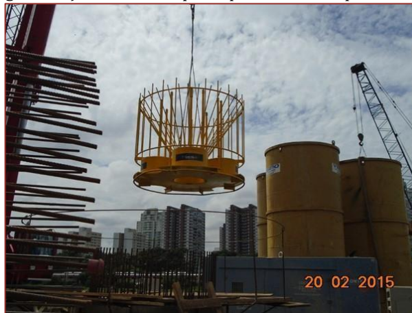
Figura 5. Içamento do suporte para células expansivas.
