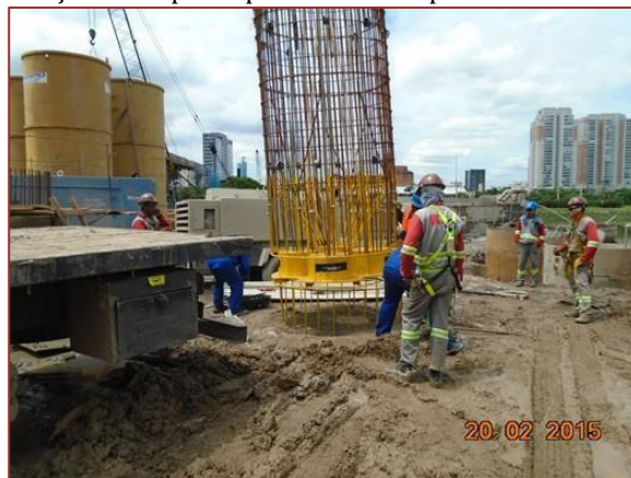
Figura 8. Fixação do suporte para células expansivas na armação inferior.
