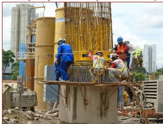
Figura 8. Fixação do suporte para células expansivas na armação inferior.
