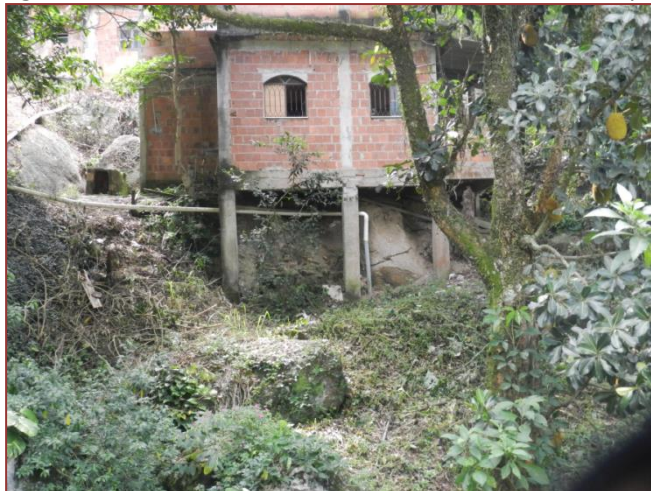
Figura 10: Deficiência de saneamento – Maceió - Niterói/RJ
