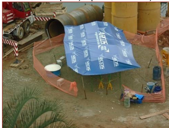
Figura 11. Barraca de proteção para instrumentação do ensaio.
