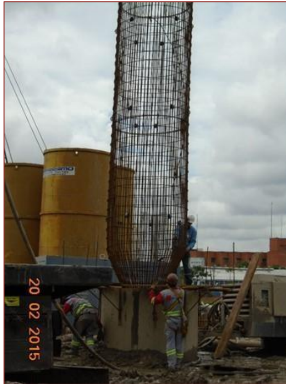
Figura 6. Instalação do primeiro tramo de armação.
