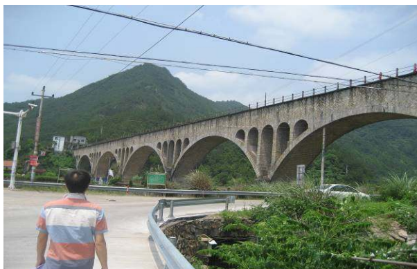
Fig. 1. An actual aqueduct in China
