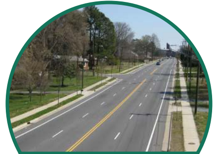
Hickory Grove Rd
