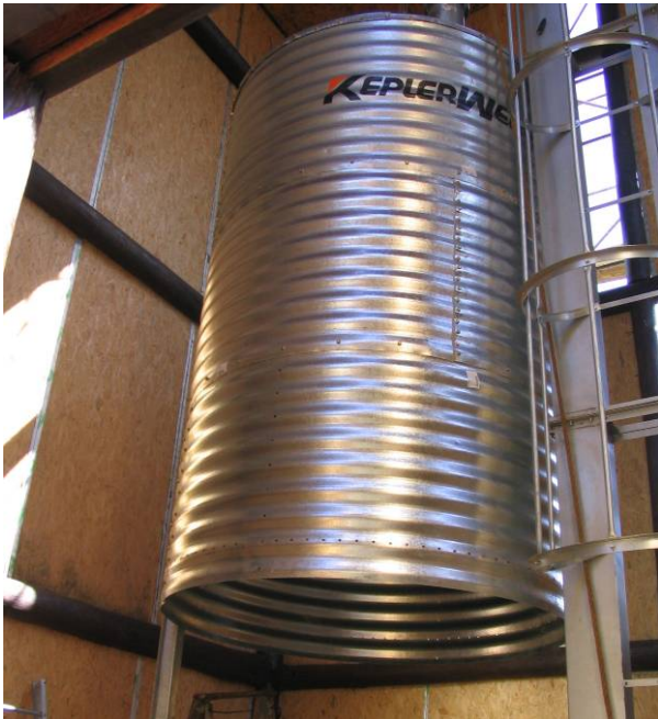
Figura 7.22 – Içamento do corpo do silo de armazenamento.
