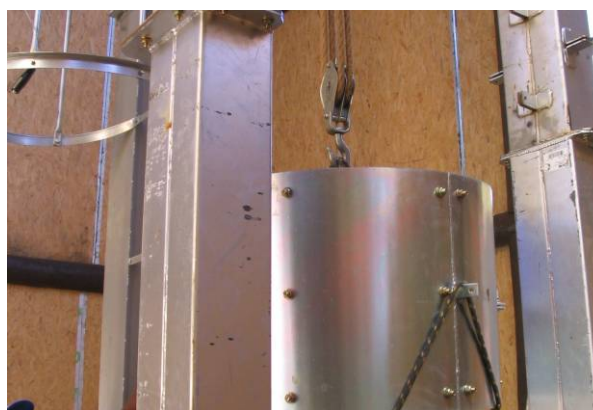
Figura 7.21 – Içamento para a montagem dos anéis do silo-piloto.
