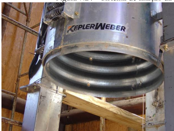
Figura 7.25 – Revestimento em chapa ondulada dos anéis.
