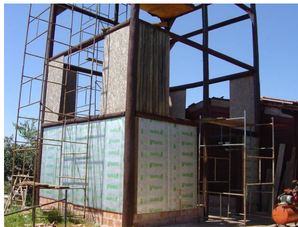
Figura 7.15 – Montagem dos painéis do edifício experimental.
