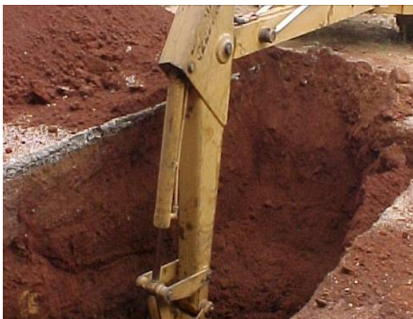
Figura 7.14 – Abertura para o poço do elevador e para as moegas.
