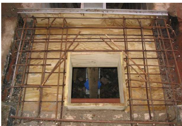
Figura 7.18 – Montagem parcial das armaduras da laje.
