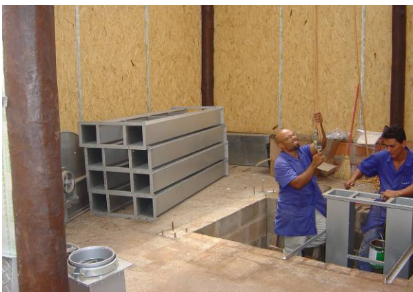
Figura 7.16 – Montagem do elevador de canecas.
