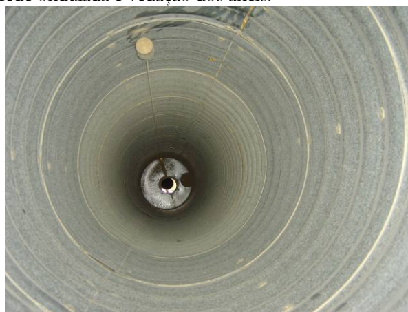
Figura 7.26 – Visão interna do revestimento interno.
