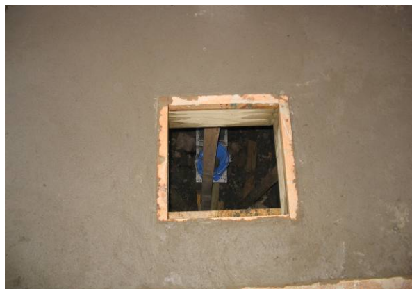
Figura 7.19 – Laje concretada para a colocação do silo-piloto.
