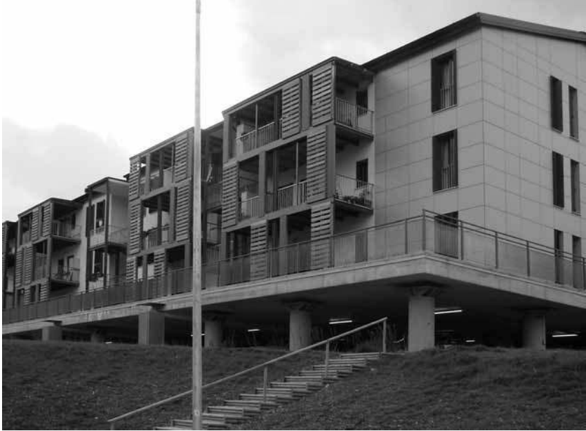
FIGURA 2 – Habitações provisórias CASE em Bazzano, arredores de L’Aquila (foto do autor) As colunas do isolamento de base suportam o edifício e protegem-no das oscilações sísmicas
