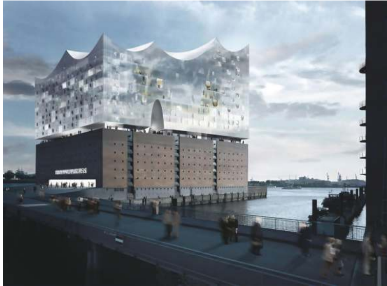
Figure 5. Herzog & de Meuron, Elbe Philharmonie. Copyright Herzog & de Meuron.
