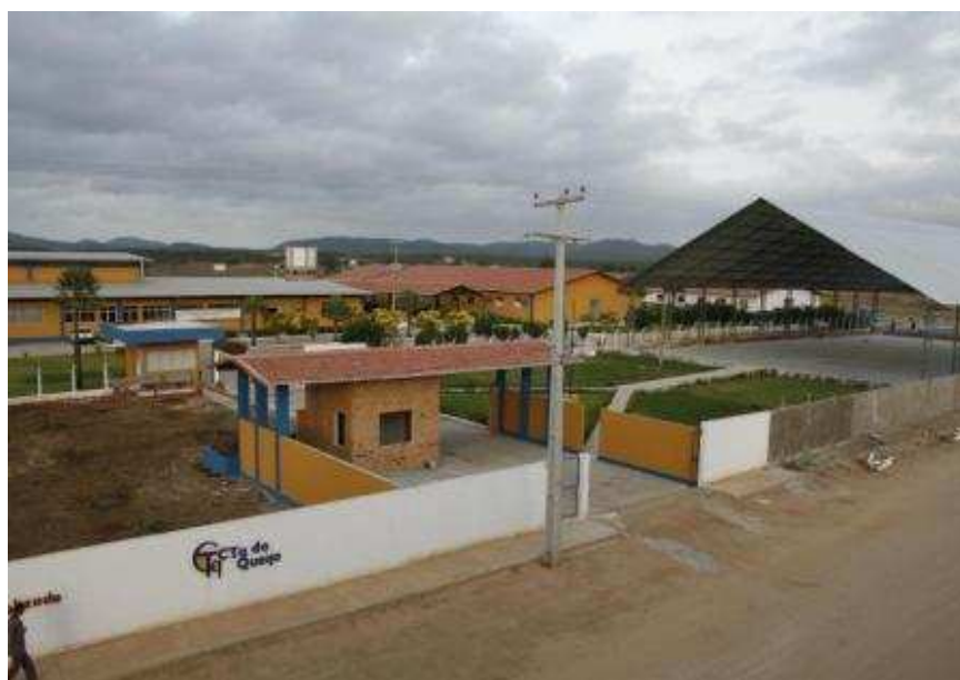
Figura 1 – Vista aérea da Unidade de Ensino de Currais Novos-RN.
