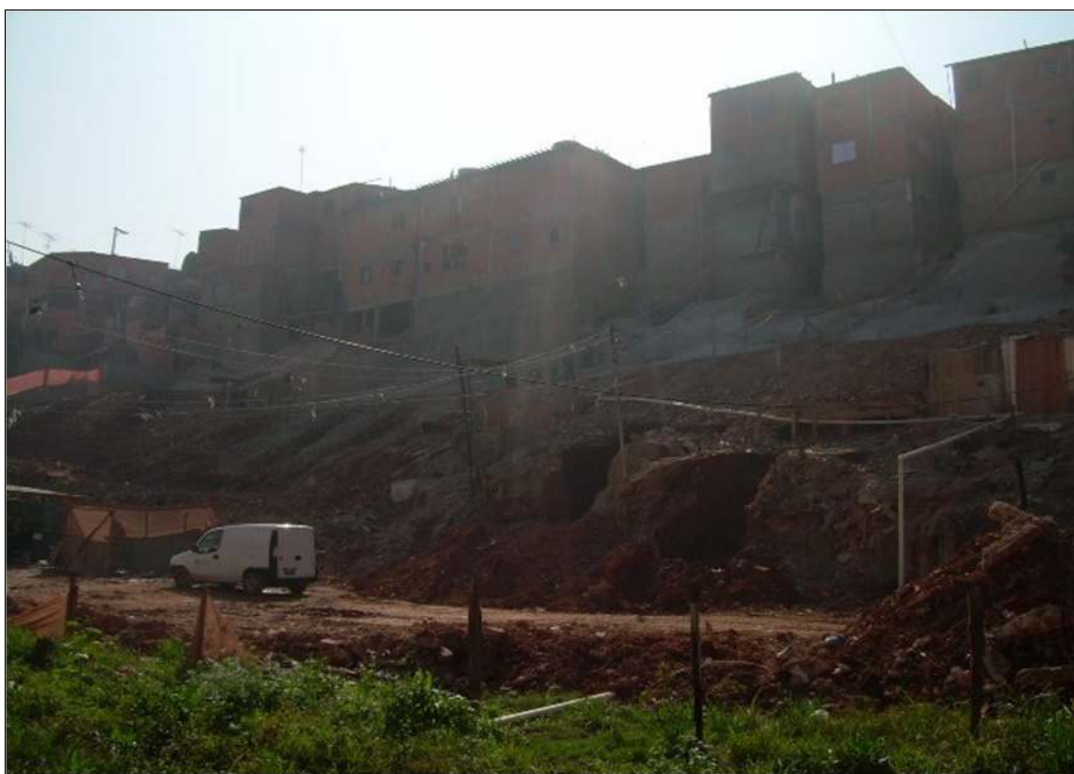
Figura 2 - Obras na área de risco do Grotão Fonte: SEHAB (São Paulo, 2013).
