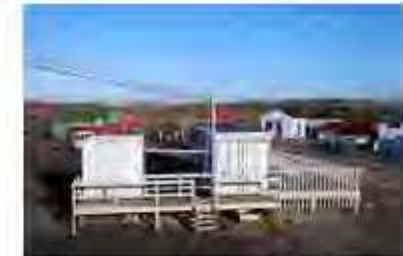
På mandag begynder elektrolyseanlægget i Nakskov produktionen af brint. Klik for større foto
