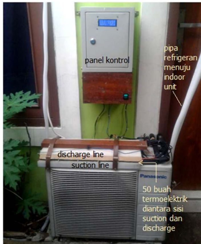
Gambar 10. Hasil Modifikasi Termoelektrik Generator pada Air Conditioner
