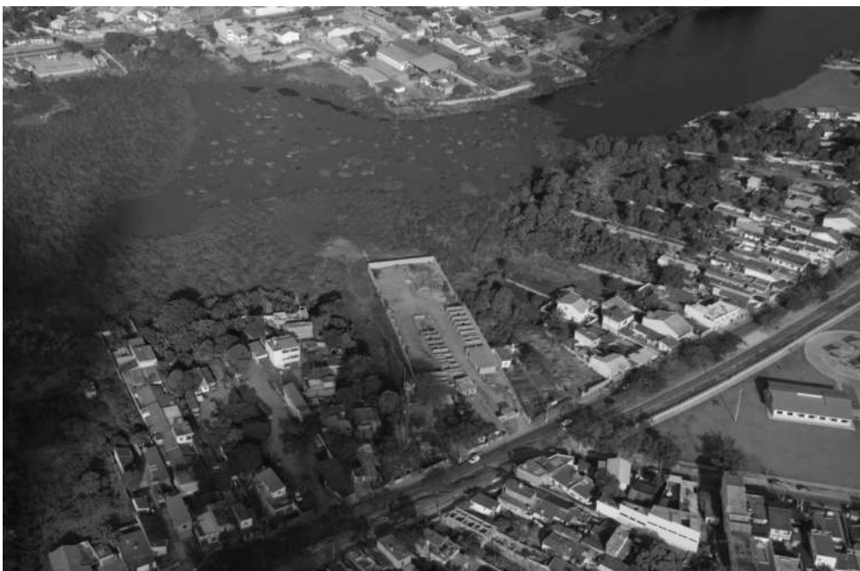
Figura 3 – Lagoa do Vigário – A ocupação desordenada
