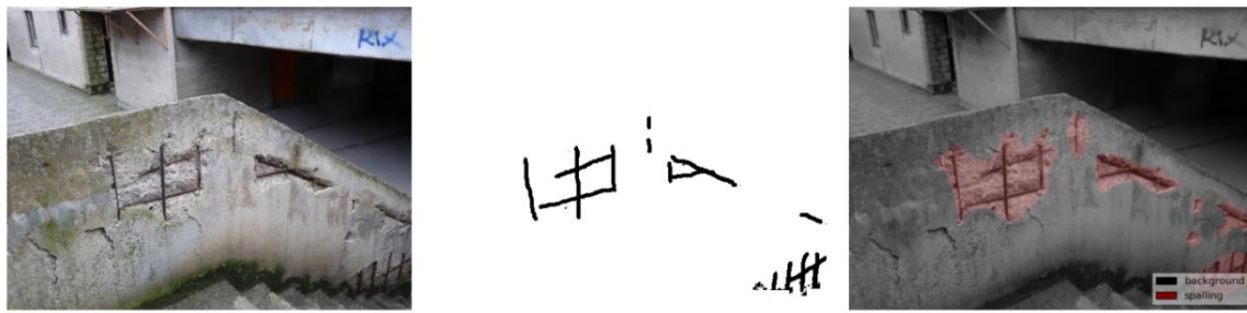
Figura 3 - Imagem original, seguida por seu rótulo (label), e a detecção da fragmentação
