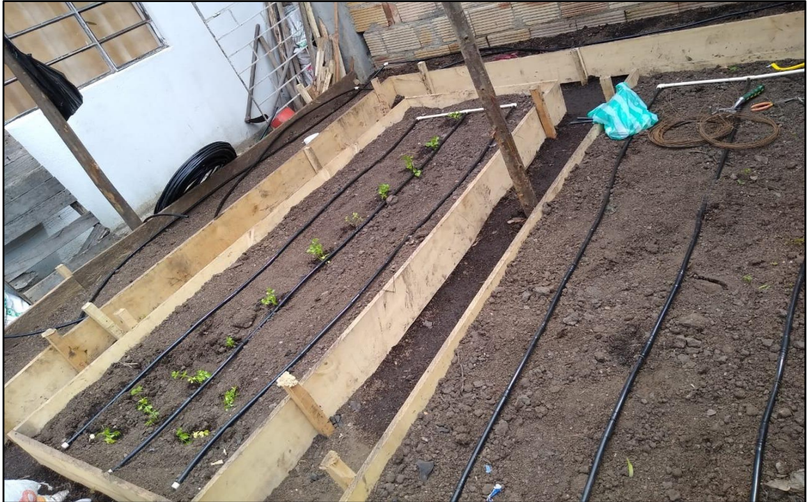
Figura 33 Instalación del sistema de riego
