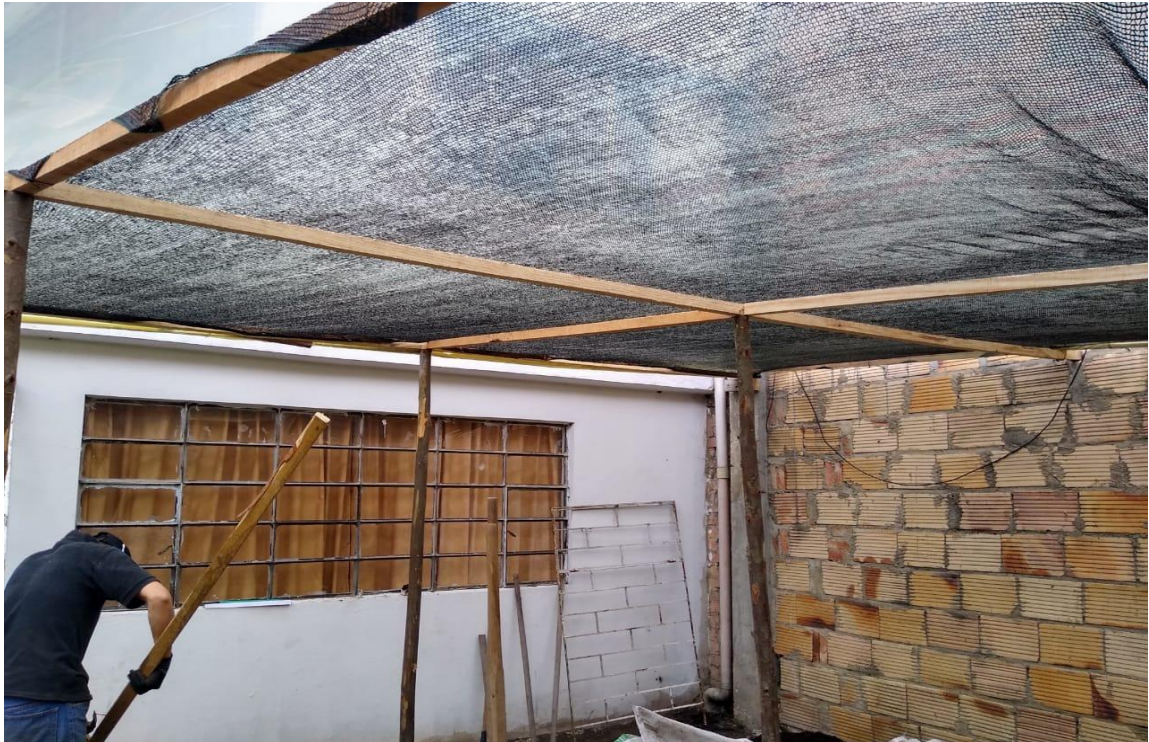
Figura 31 Instalación de techo y paredes del invernadero
