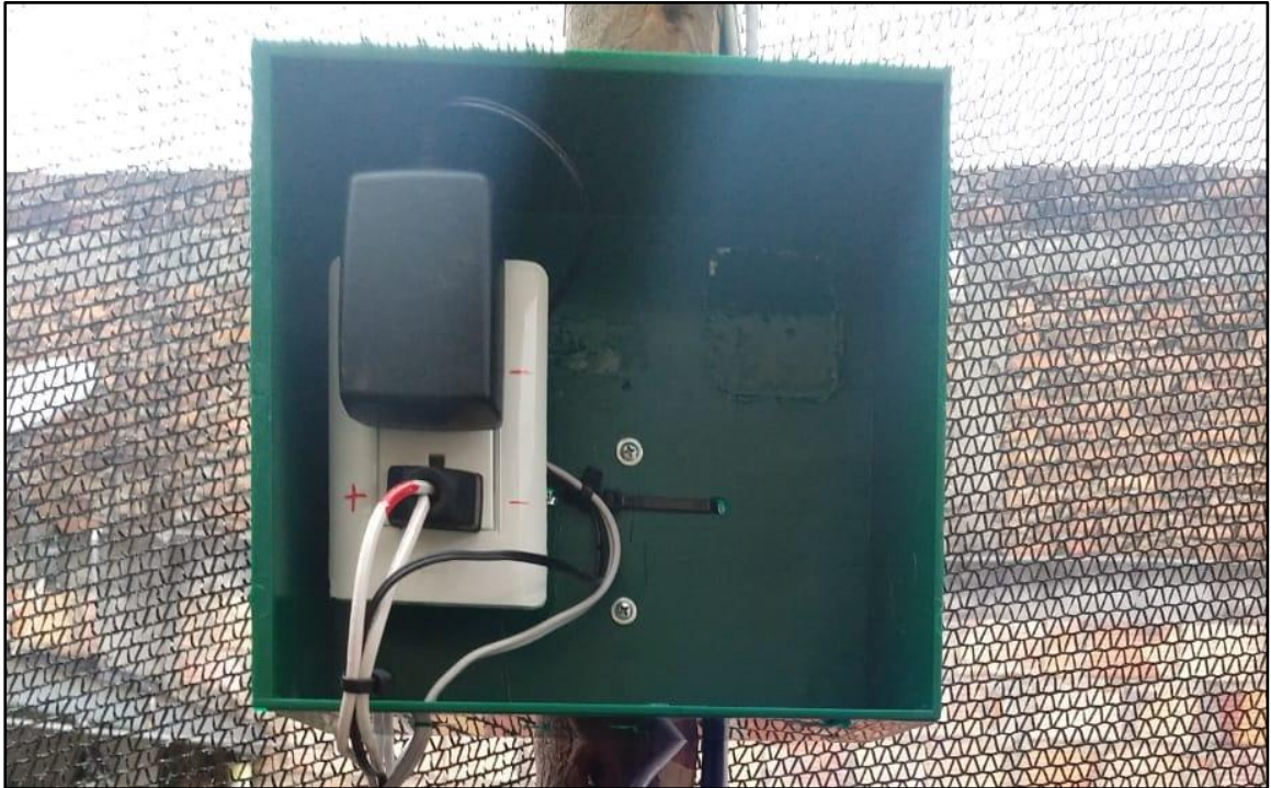
Figura 36 Instalación del circuito eléctrico
