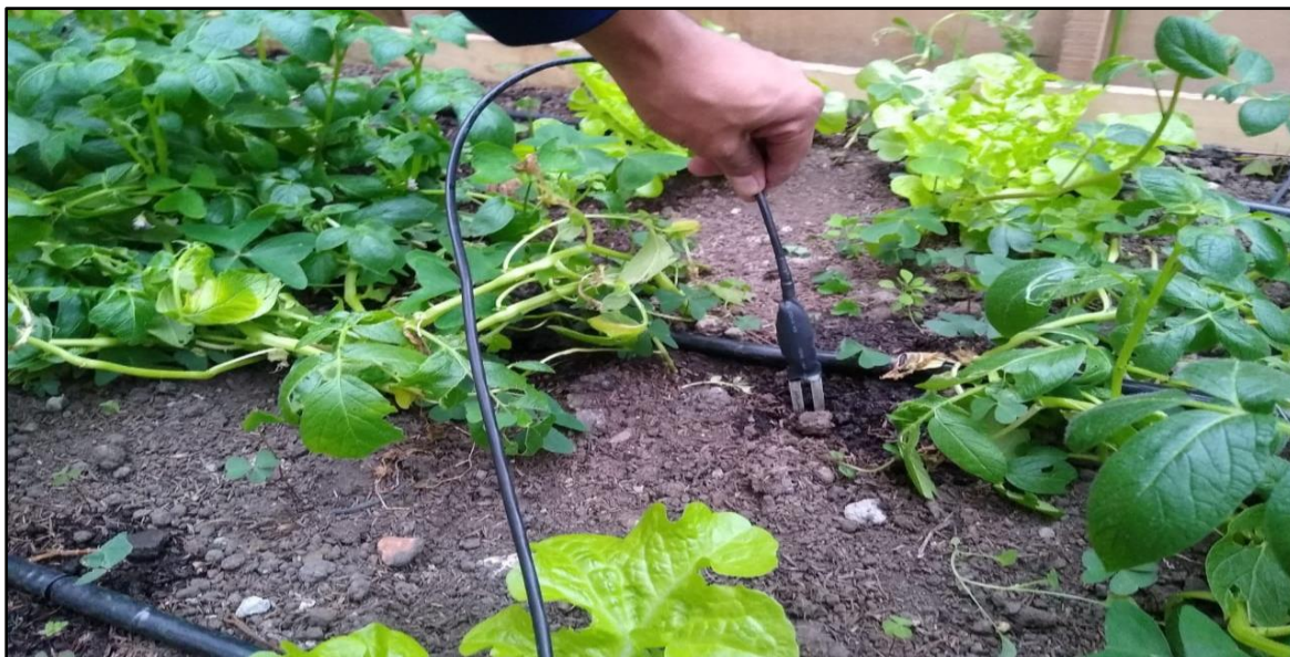
Figura 35 Instalación de sensores
