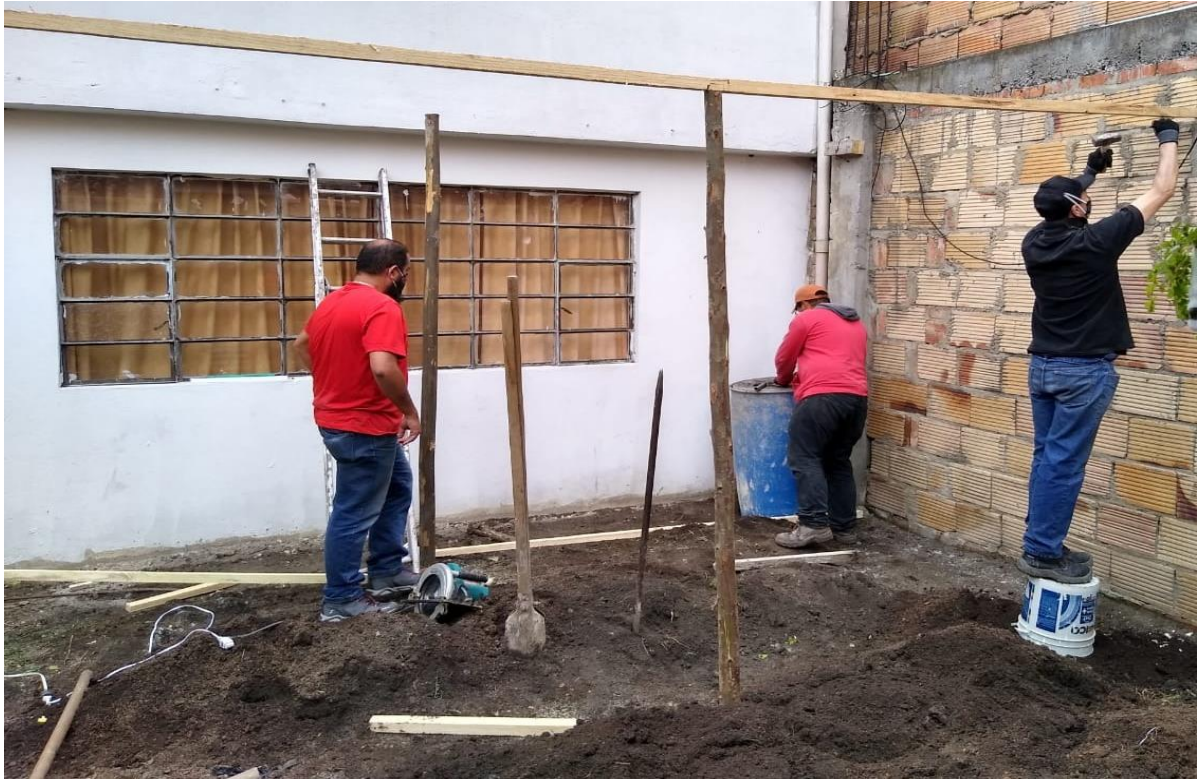
Figura 30 Proceso de construcción bases del invernadero
