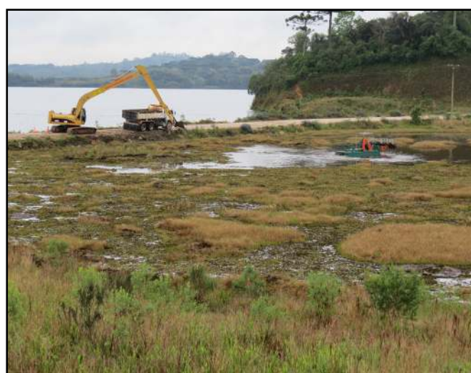
Figura 2b - Barco C96 agrupando plantas para a retirada e carregamento pela escavadeira hidráulica de braço longo CAT 320 C
