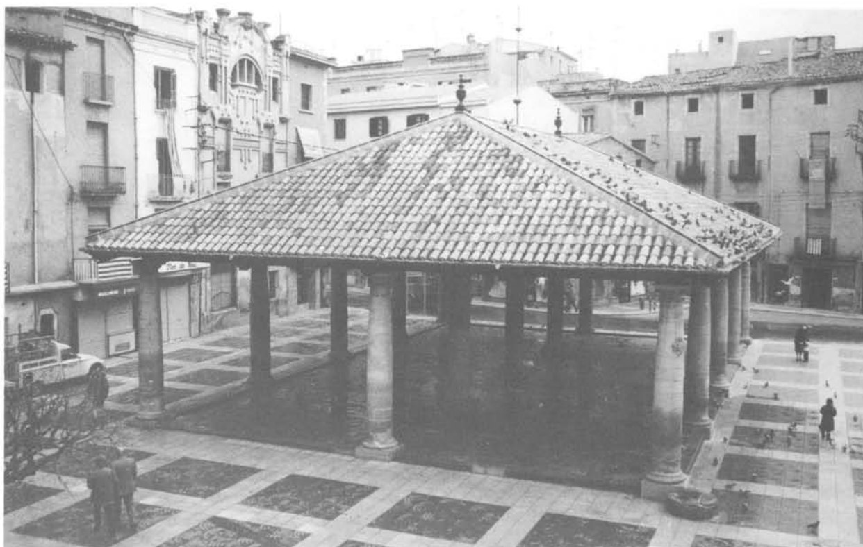
Obra acabada (el pavimento exterior es el mismo de antes de la intervención).
