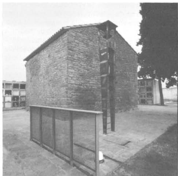
Exterior. Campanario nuevo.
