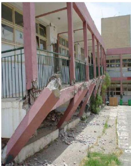
a) 2003 Boumerdès, Algeria quake
