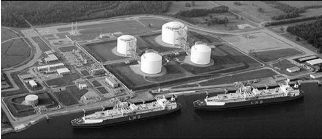
Figure 1: LNG Import Terminal
