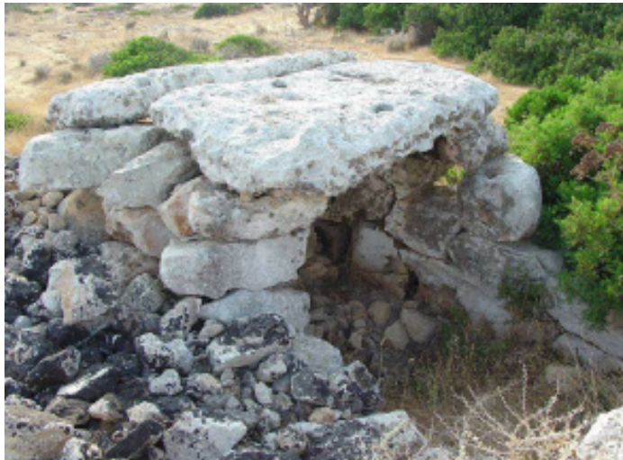
Imagen 33 Restos de la cubierta de la naveta de Torre del Ram (TDR- 02).
