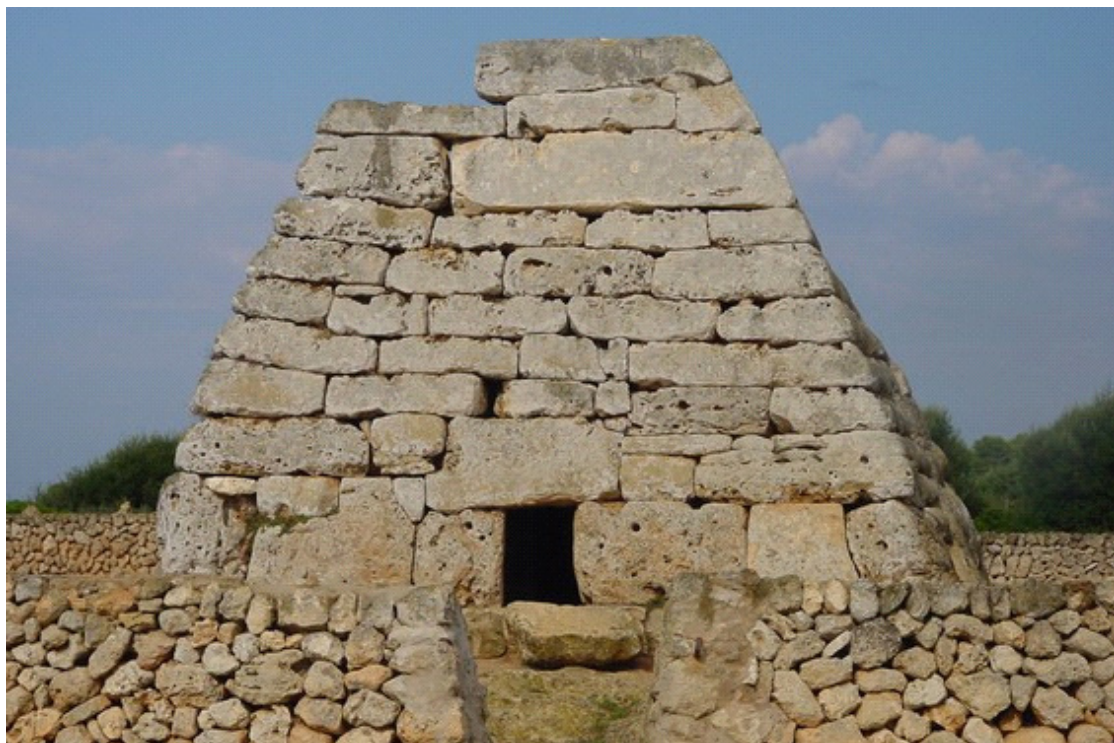
Imagen 17 Fachada de la naveta des Tudons en la actualidad.
