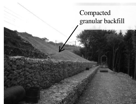
(d) Backfilling and regrading upper slope.
