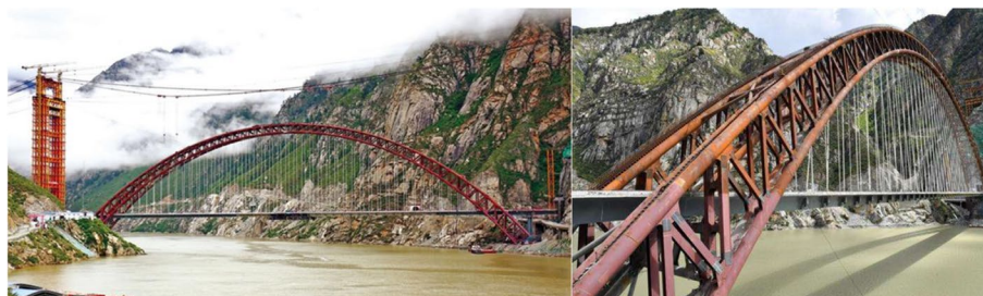
Fig. 4 The Zangmu Bridge crossing Yarlung Zangbo River
