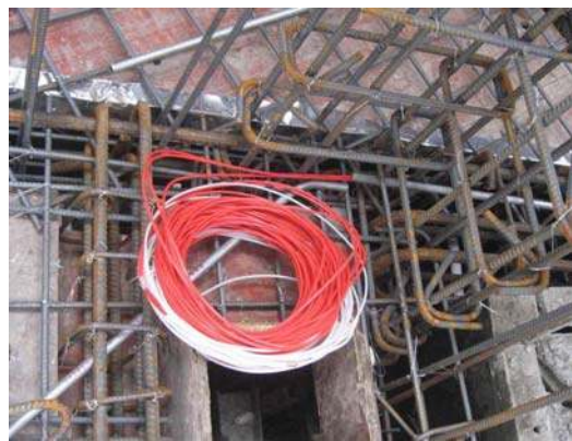
(d) Protection of cables
