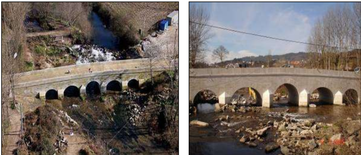
Figura 5 e 6. Ponte de alvenaria de pedra em Vila Fria Portugal [13]
