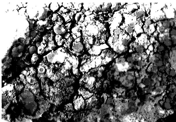
Fig.8.- Hormigón del Garum (BC-17). Colonización masiva de líquenes en la superficie.
