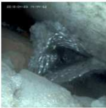
(d) The GFRP fixture
