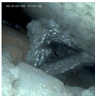
(d) The GFRP fixture
