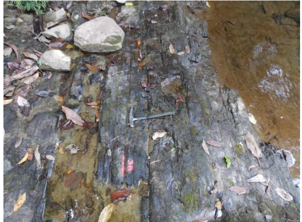
Parte superior de la Lidita Inferior: Disminución en la competencia de la roca la cual genera que la quebrada cubra el afloramiento.
