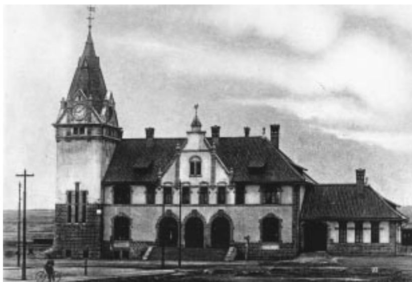
FIGURE 3. Qingdao Rail Station (1904) ( Ansichten von Tsingtau und dem Hinterlande [n.p.: n.d., ca. 1910]).
