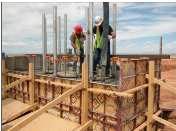
concrete pour for the thrust block
