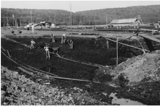
Fig. 4 Peat mining in the Wenigmoos, Sept/Oct 1942. The watertable was lowered by pumps (visible on the right side) (Source: Archive “Abteilung für Sturkturverbesserungen und Produktion des Amtes für Landwirtschaft und Natur des Kantons Bern”)
