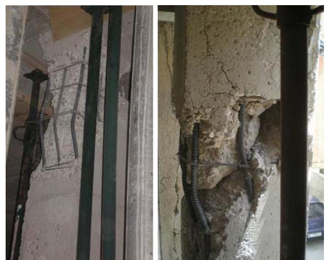
Fig. 4. Rotura de soporte de hormigón armado en edificio de viviendas, durante el terremoto de Lorca en 2011. Situación insegura a evitar y que pretende evitarse aplicando el concepto de columna fuerte-viga débil.
