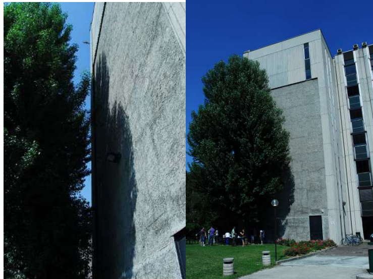
Figure 8 The Edificio 21 test façade.
