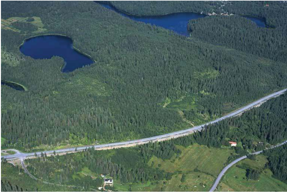
Figure 26. Aerial view of Vuores, Mäyränmäki ( www.tampere.fi/vuores )
