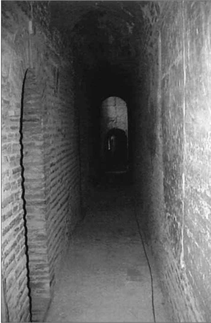
Lam. 1. Adarve subterráneo de la Torre de Comares.
