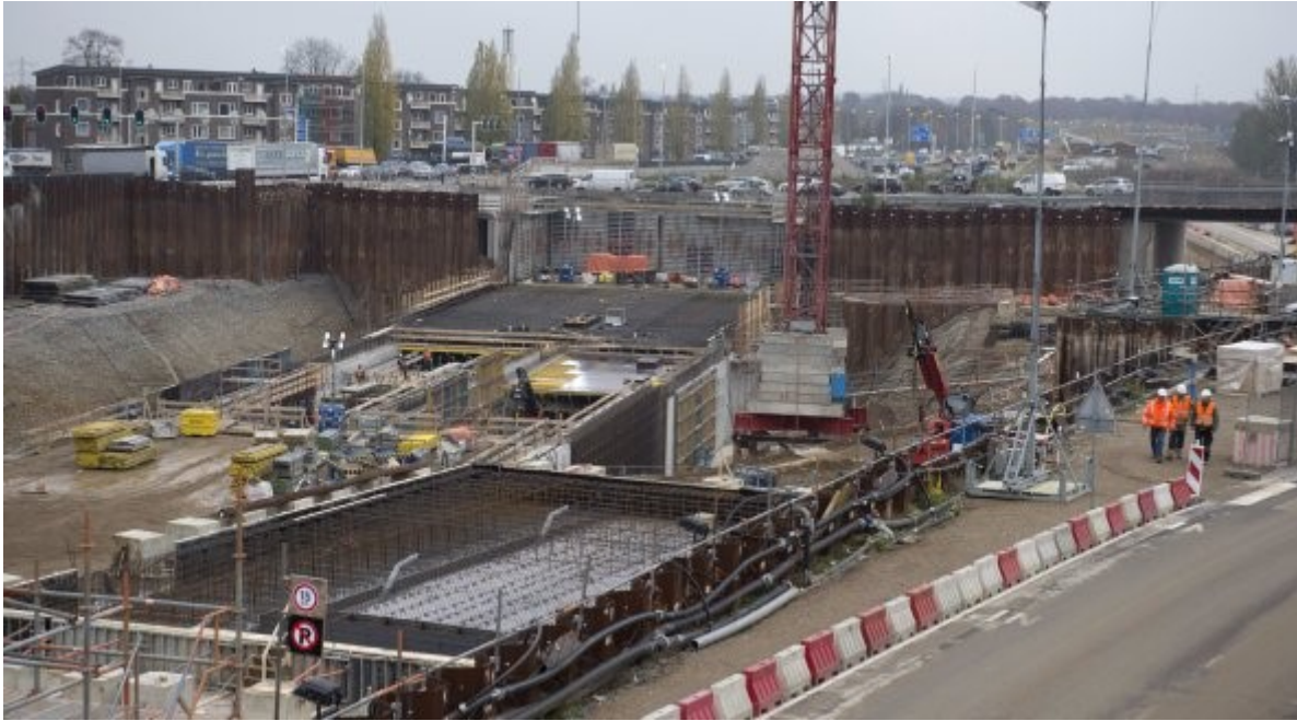
Bouwwerkzaamheden bij de A2-tunnel in Maastricht, waar Regio Rail ook aan meebouwt.
