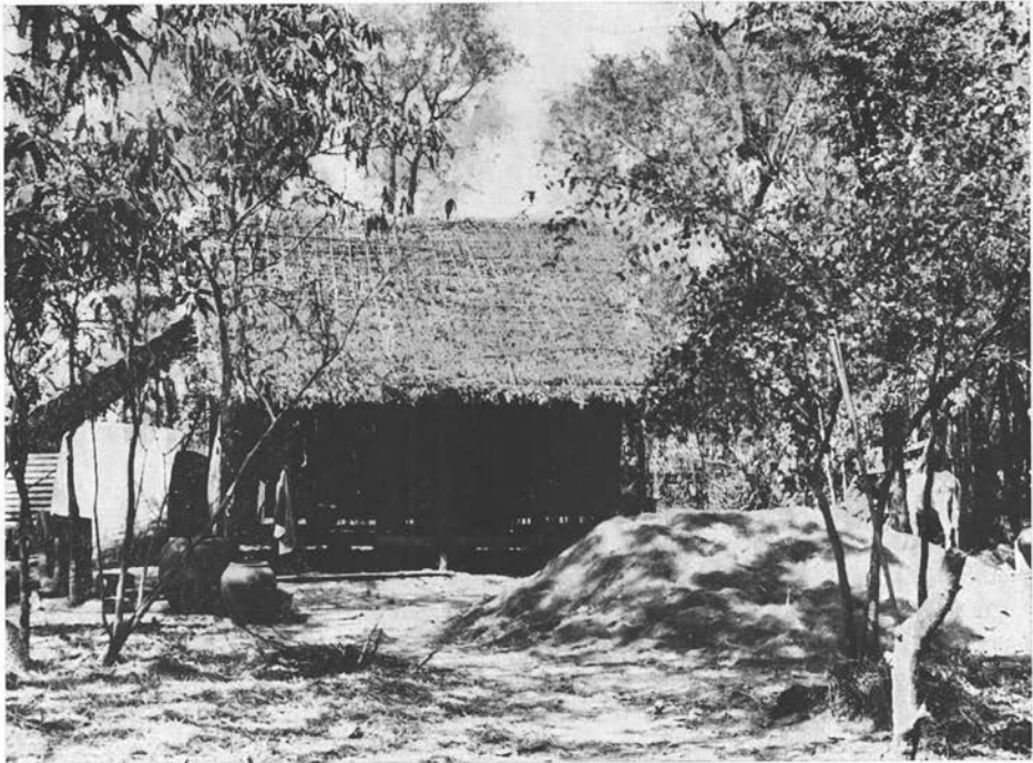
FIG. 6. — Maison typique du village d'Okpo avec des jarres en terre au premier plan
