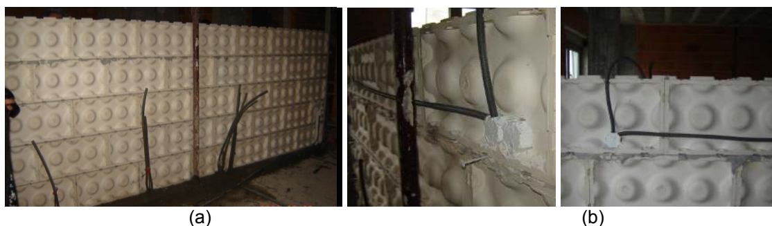
Figura 2. Construção da parede protótipo em obra - elevação do primeiro pano de parede até à colocação das infra-estruturas; (a) vista da face interior da parede; (b) localização das tubagens.
