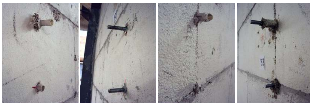
Figura 7. Rotura local após incremento de carga; (a) bucha plástica –zona oca ; (b) bucha química – zona oca; (c) bucha plástica – zona de junta; (d) bucha química –zona de junta
